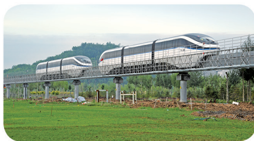
云轨一号线花博园段工程
